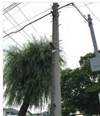
街灯の設置(東大宮6丁目)
