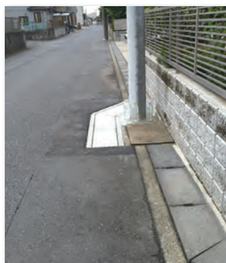
U字溝水路の確保(春岡2丁目)
